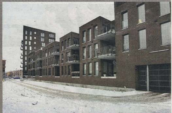
De overgang van laag- naar hoogbouw.
