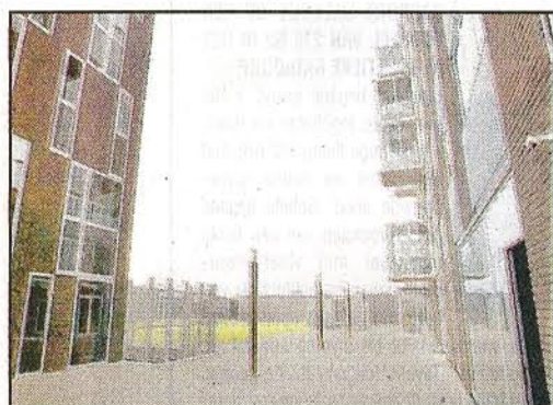
• Balkons, waarvan er een aantal over twee verdiepingen zijn uitgerekt, accentueren de achtergevel van het woongebouw.
