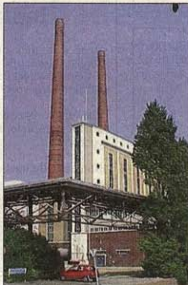
De schoorstenen zijn zo'n 80 m.
